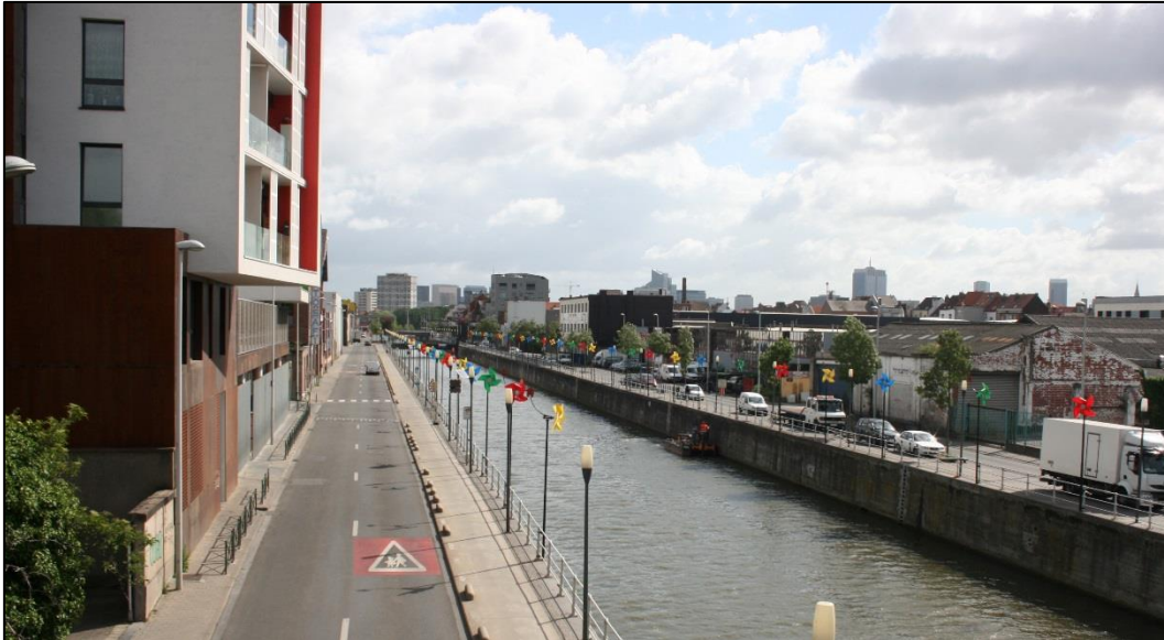
Photo 6 : Vue dans l'axe du quai de Mariemont depuis le Pont Delacroix (photo : CSD Ingénieurs, juin 2017)
