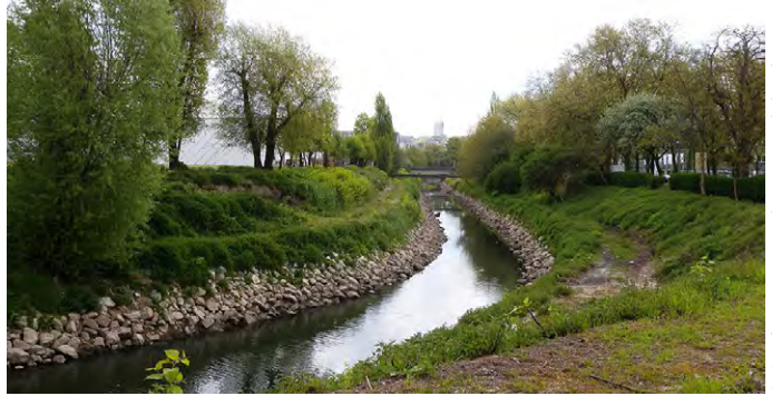
6. Aménagement plus naturel des berges
