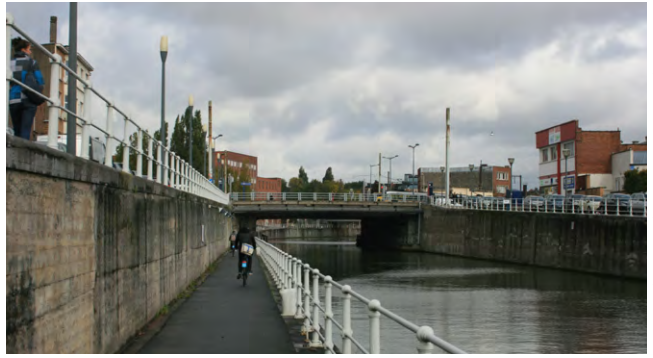
Traversée sous le Pont de Cureghem
