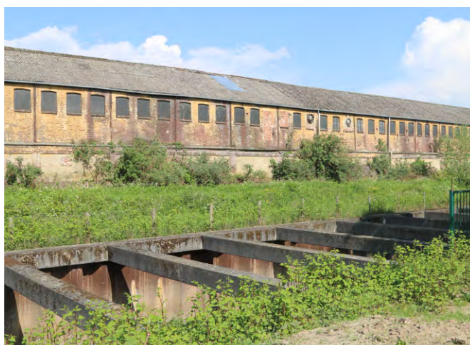
photo de la situation existante
