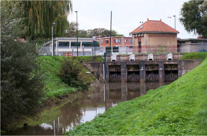
7. interconnexion entre la Senne et le canal à Anderlecht
