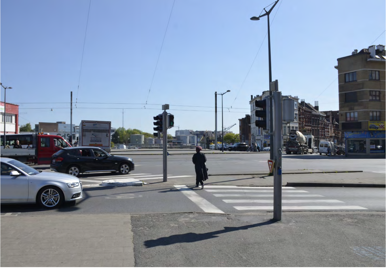
1. Espace public linéaire au niveau du Square Vandervelde
