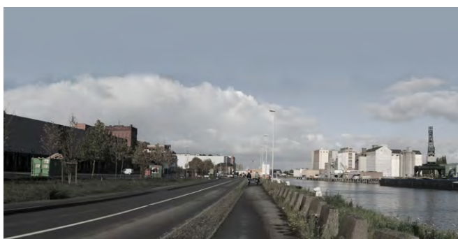
Photo de la situation existante - tronçon «quai»
