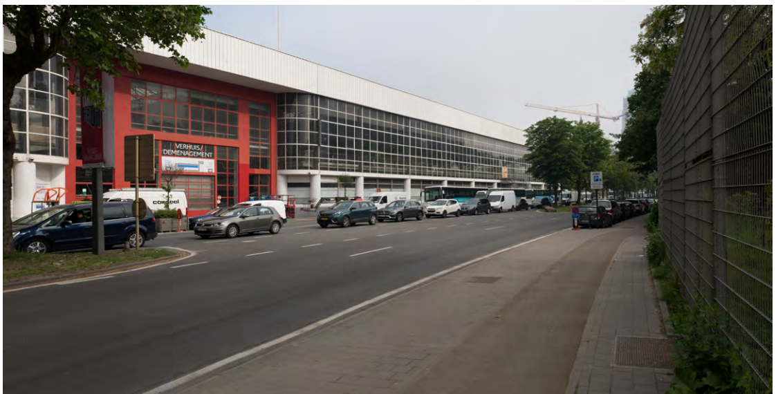
Photo de la situation existante
