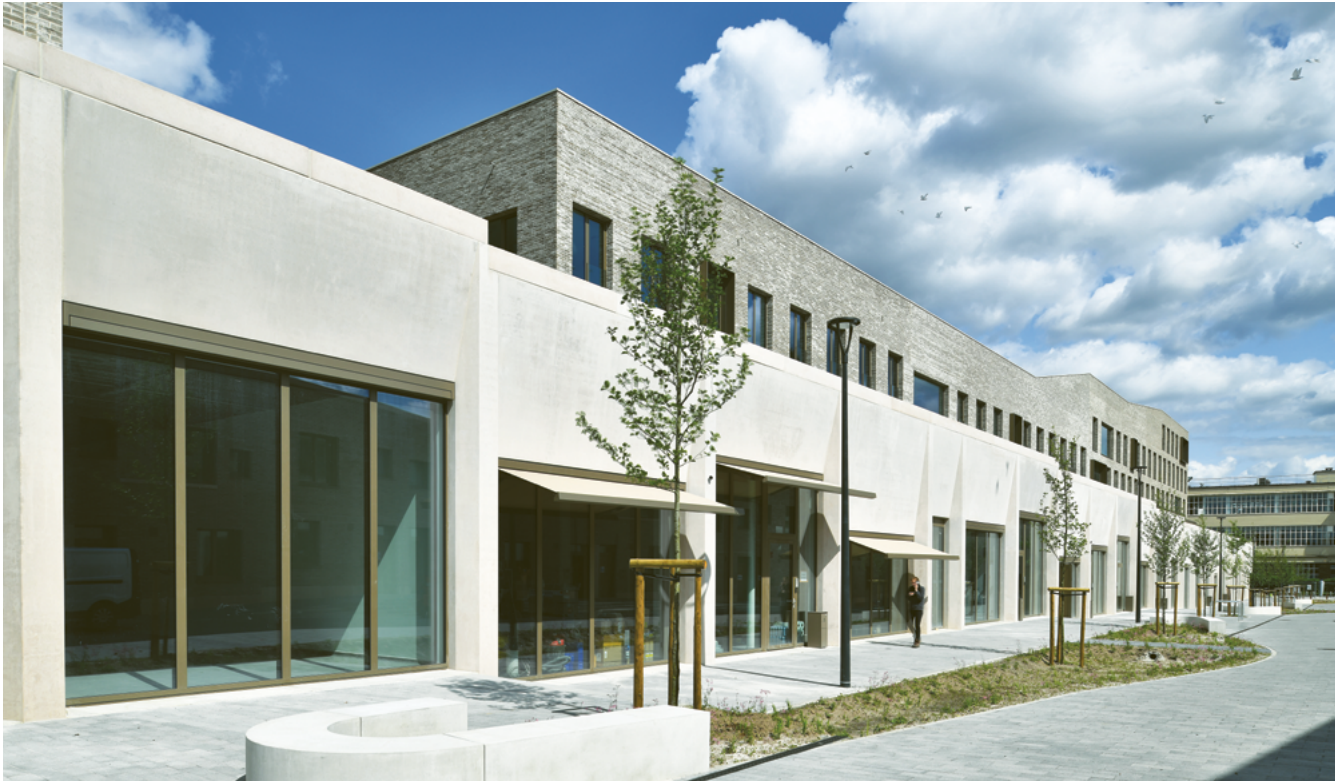
↑ Photo 7 Ateliers au rez-de-chaussée dans le projet CityCampus, avenue Gryson, Anderlecht © Serge Brison, mai 2023 Foto 7 Gelijkvloerse werkplaatsen in het project CityCampus, Grysonlaan, Anderlecht © Serge Brison, mei 2023
