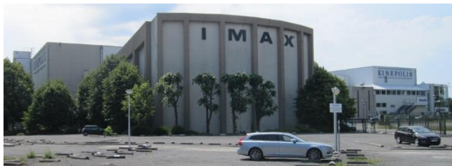
Vue du Kinépolis depuis le nord (ARIES, 2020)
