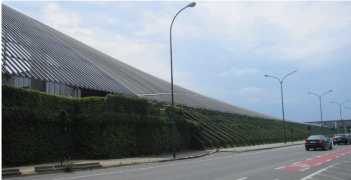
Vue de la structure couvrant le parking depuis la chaussée Romaine (ARIES, 2020)
