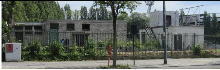
Volume des vestiaires et sanitaires vue depuis l'av. Houba de Strooper (ARIES, 2020)
