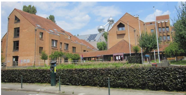
Constructions de la « Maison Heysel » (ARIES, 2020)
