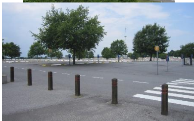
Vue de constructions longeant la chaussée Romaine, côté Région flamande (à gauche) et du parking C (à droite)(ARIES, 2020)
