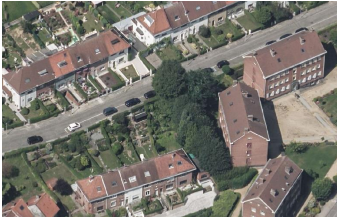
Vue aérienne sur la cité-jardin Verregat (Bing maps, 2021)
