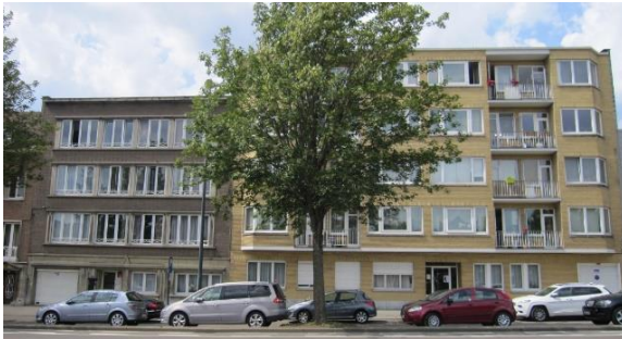
Constructions sur l'avenue Houba de Strooper
