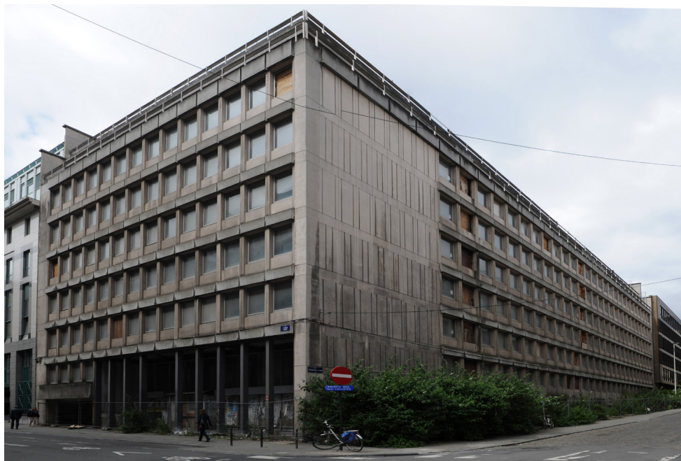
↑ Foto 5: Aarlenstraat 104 © kantoor RE&US
