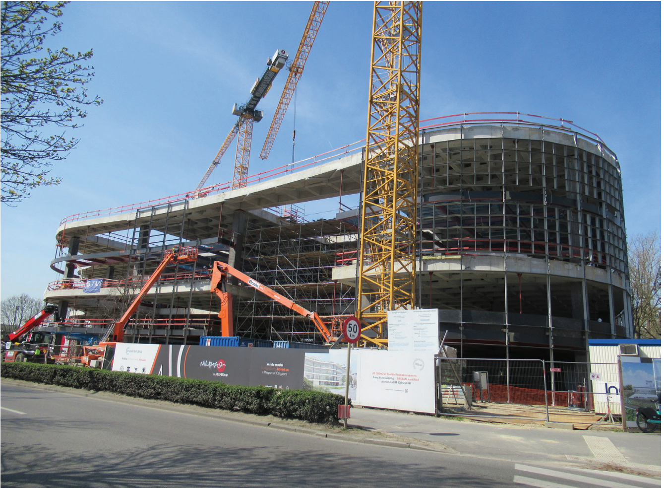
↑ Photo 10 Construction d'un immeuble à Anderlecht avec des espaces internes adaptables en fonction des besoins (avril 2023) Foto 10 Realisatie van een gebouw in Anderlecht met interne ruimten die kunnen worden aangepast aan de behoeften (april 2023)
