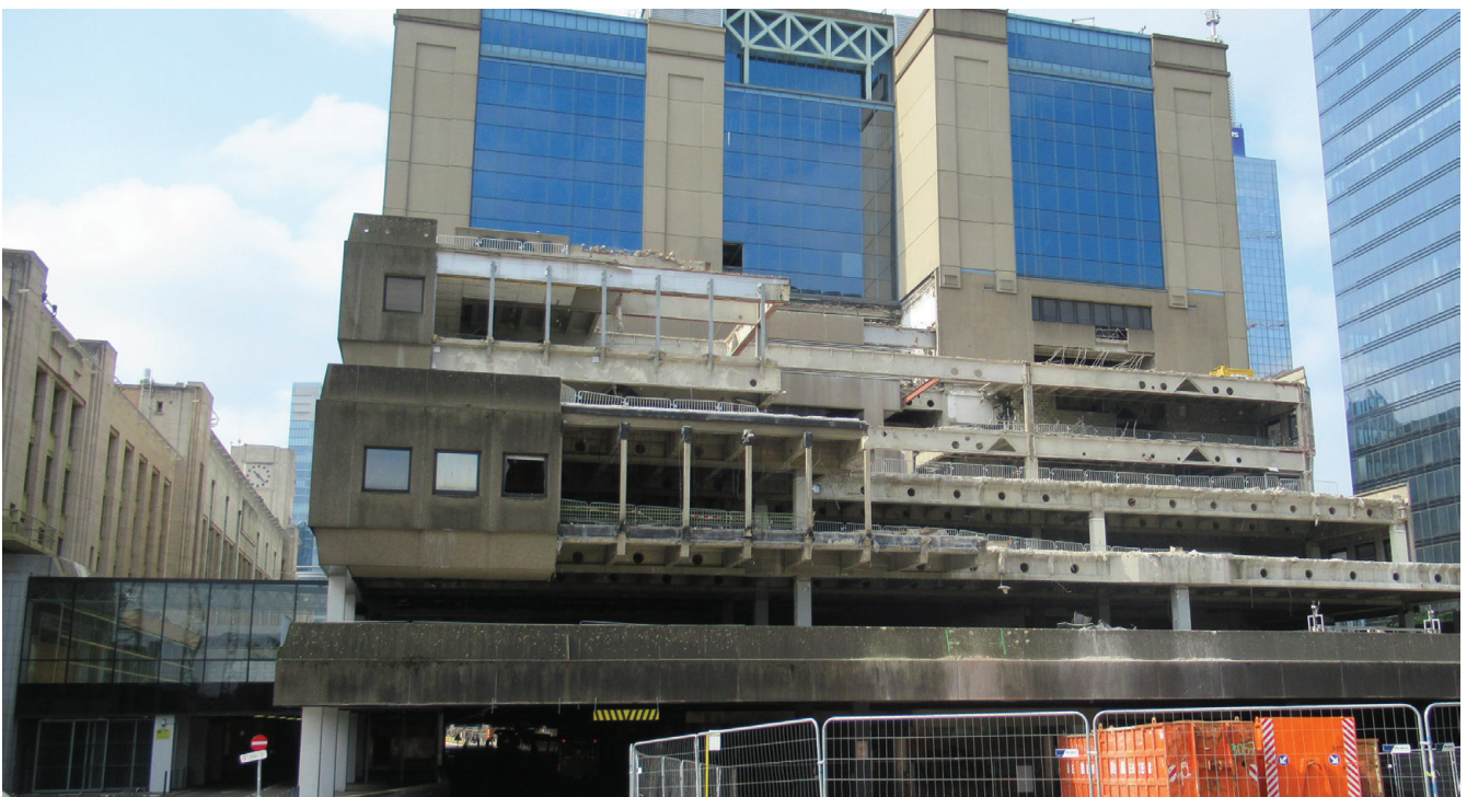
↑ Photo 4 Déconstruction en cours du Centre de Communication Nord (CCN), en vue de la réalisation du projet NØR (mai 2023) Foto 4 Het Communicatiecentrum Noord (CCN) wordt afgebroken met het oog op de realisatie van het NØR-project (mei 2023)
