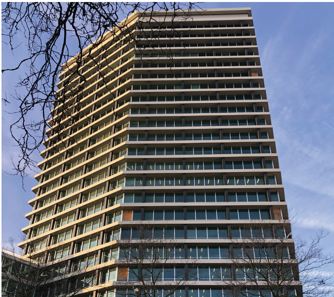
↑ Photo 6 Immeuble de bureaux «The Louise» en cours de finalisation (février 2024)
