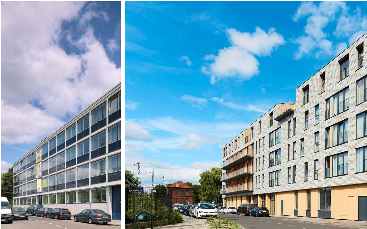
Foto 9 en 10: Kantoren in de Paviljoenstraat te Schaarbeek, vóór en na conversie (41 gerealiseerde woningen – Project Paviljoen) ©Yvan Glavie
