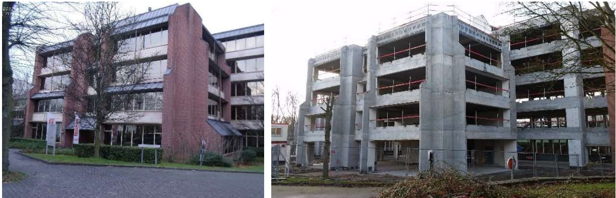
Foto 6 en 7: Kantoor aan de Plejadenlaan vóór en tijdens de werken voor conversie tot woningen door het Woningfonds. © Woningfonds
