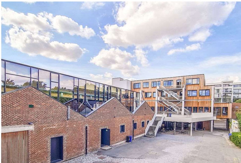
Foto 5: École active - Constructie van een sportzaal op het industriële deel van de site. Bron 2 © 2022 by ÁRTER Architects
