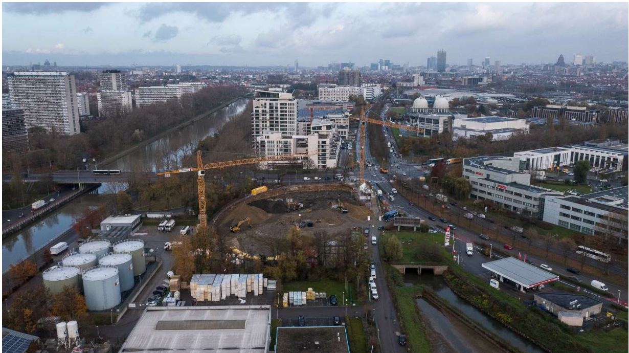
Foto11: Werken in uitvoering voor het project MOBILIS, voorbeeld van omkeerbaarheid van het toekomstige gebouw © Alheembouw/Mobilis
