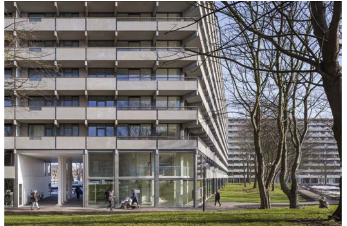
REF: deFlat, Amsterdam Zuid-Oost, NL Architects + XVW architectuur
