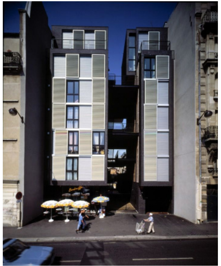
REF: Logements de la poste, rue de l'Ourcq, Paris, Philippe Gazeau
