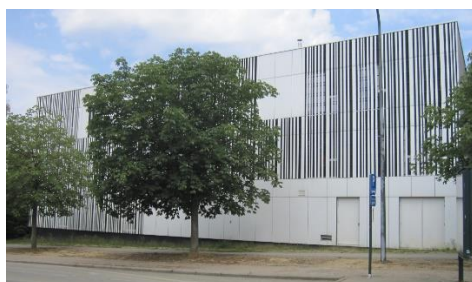
Vue de l'extension de 2014 de l'école des Magnolias (ARIES, 2020)
