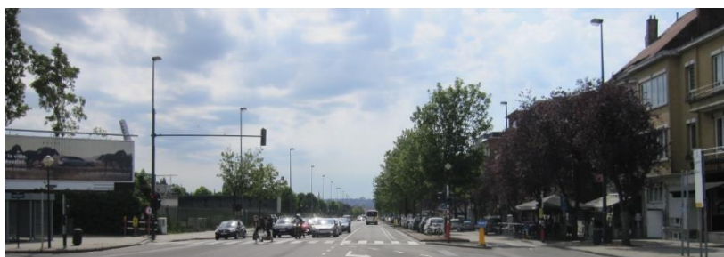
Figure 67 : Vue de l'av. Houba de Strooper au droit du site (ARIES, 2020)
