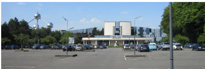
Vue du Trade mart et du parking qui le précède côté av. de Madrid (ARIES, 2020)
