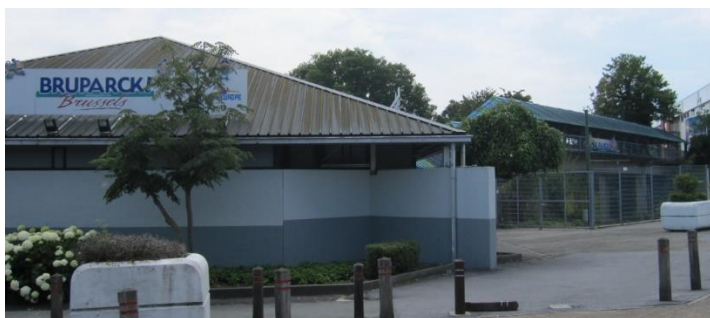
Vue de la passerelle d'accès depuis le parking T (ARIES, 2020)
