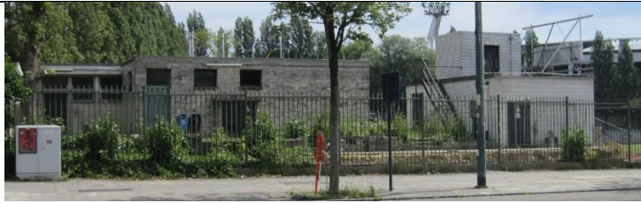
Volume des vestiaires et sanitaires vue depuis l'av. Houba de Strooper (ARIES, 2020)
