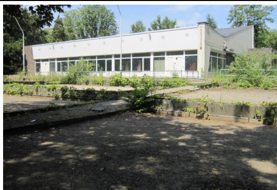
Bâtiment du Léo Pétanque Club et terrains de pétanque qui l'entourent (ARIES, 2020)
