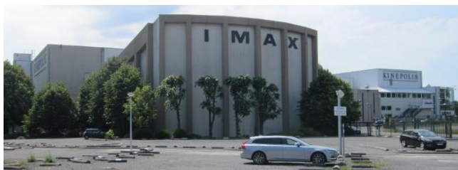
Vue du Kinépolis depuis le nord (ARIES, 2020)
