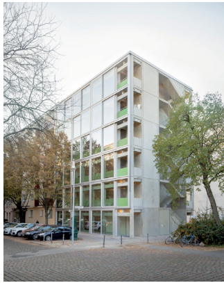
Wohnregal apartments and ateliers, FAR Frohn&Rojas, Berlijn, 2019 Dikke gevel als overgang tussen het intieme en de stad.
