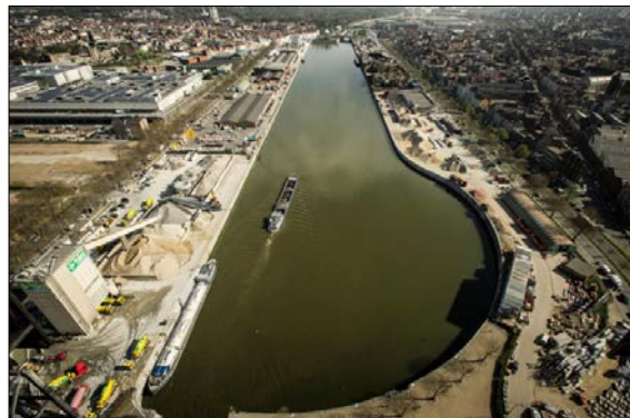
Figure 46. Vue sur le bassin Vergote (GS-ESF, 2016)
