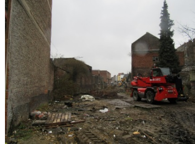
Figure 131. Parc de la Senne - tronçon en chantier
