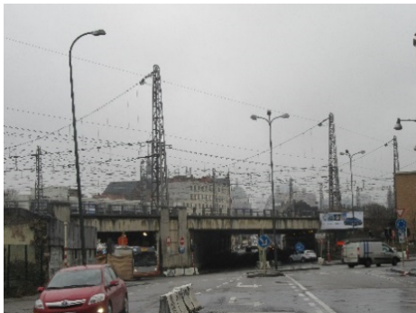
Figure 58. Jonction ferroviaire Nord-Midi
