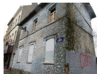
Figure 19. Maison du Garde-Barrière
