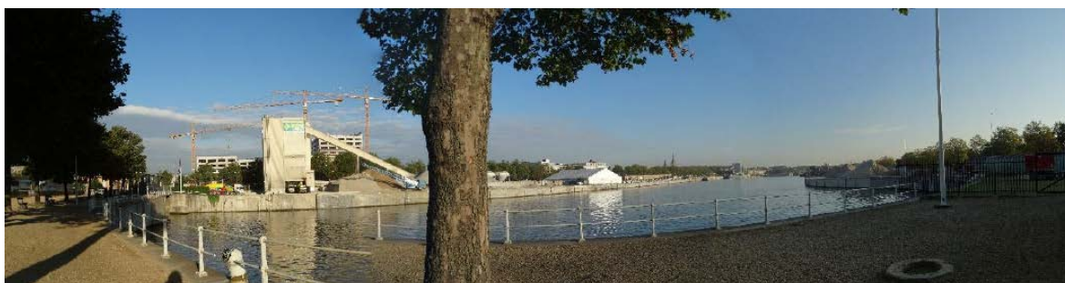
Figure 47. Vue sur le bassin Vergote de puis la courbe de giration (bMa - Equipe Canal, 2016)
