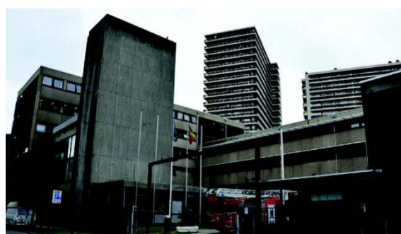
Figure 50. Vue sur les dalles Héliport (CityTools & Studio 016 Paola Viganò, 2016)
