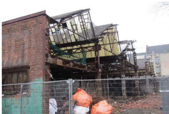
Figure 27. Hangar industriel dégradé dans le quartier Masui
