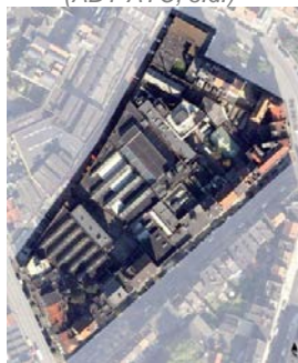
Figure 139. Intérieur d'îlot (avenue de la Reine / rue Masui / rue des Palais) (Suède 36, 2012)
