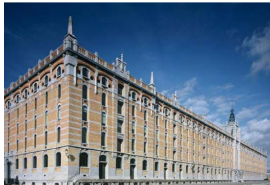
Figure 28. Entrepôt Royal à Tour & Taxis (ADT-ATO, s.d.)
