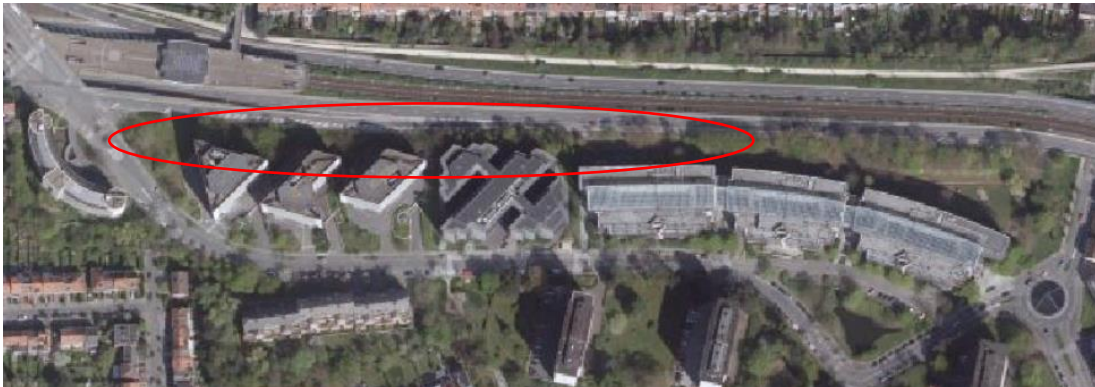
Afbeelding 1033: Doorlaatbare zone die ondoorlaatbaar zal worden gemaakt (Brugis, 2018)
