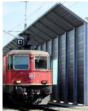
Afbeelding 768: "Overkappend" geluidsscherm
