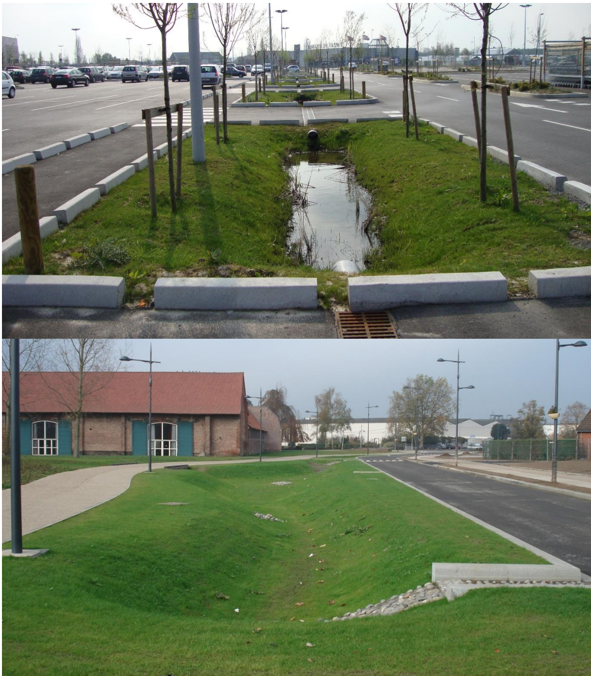
Afbeelding 56: Illustratie van infiltratiegreppels- en grachten (bron: opusenvironnement.com, 2019)
