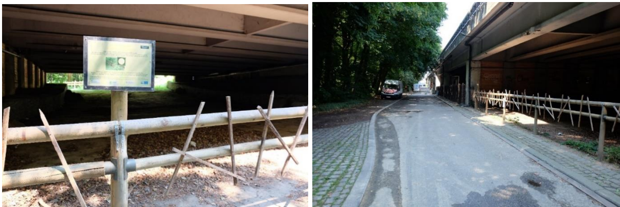
Afbeelding 1111: Faunapassage onder het viaduct van Dry Borren (ARIES, 2018)
