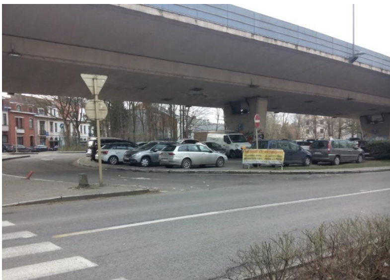
Afbeelding 457: Ongastvrije openbare ruimtes ter hoogte van het Herrmann-Debrouxviaduct (Antea, 2018)
