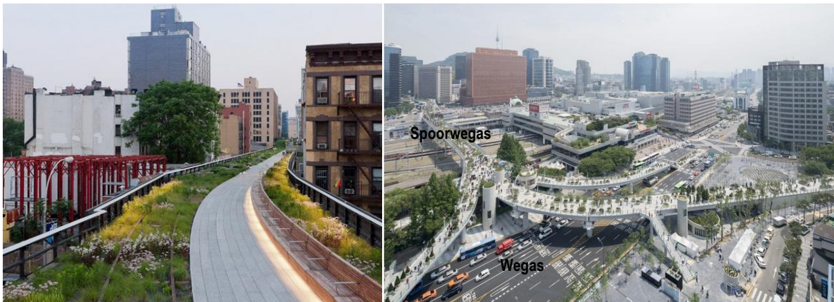
Afbeelding 621: High Line in New York (links) en Seoulo Bridge in Seoul (rechts).
